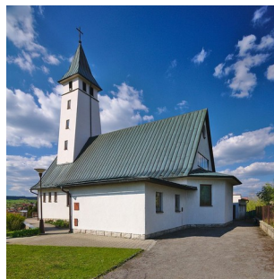
kostel v Lačnově
